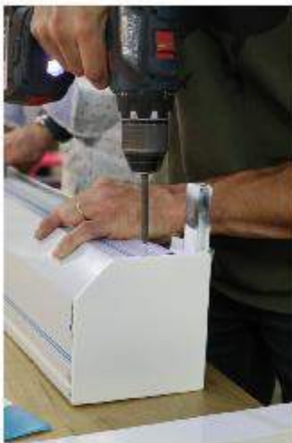
Vijs het voorste paneel op de rolluikkast
