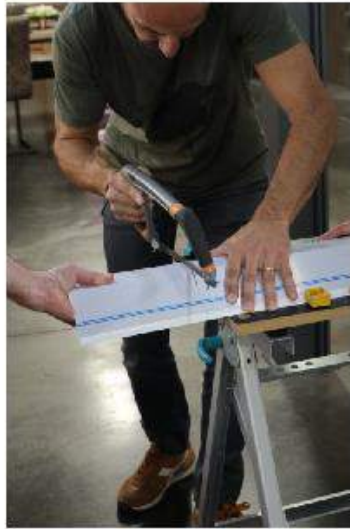
Kort de voorzijde van de rolluik-koffer in.
