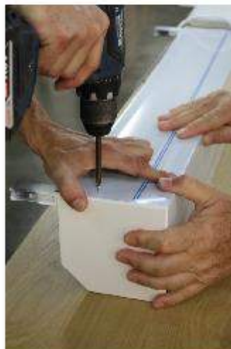
Vijs de achterwand vast aan de zijkanten van de roluijkast.
