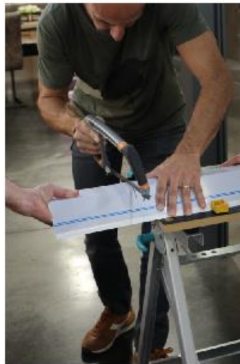
Kort de voorzijde van de rolluik-koffer in.
